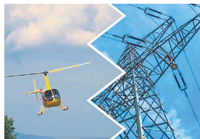
Śmigłowiec uszkodził linię energetyczną, śledztwo trwa
