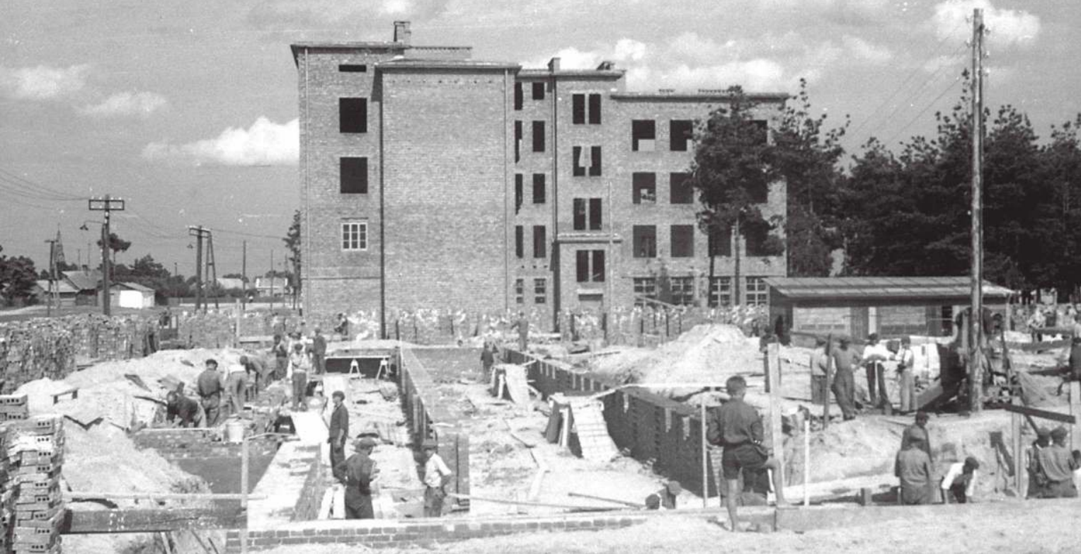
1948 r. Budowa dwóch pierwszych powojennych bloków mieszkalnych w Stalowej Woli (nie licząc jednego bloku na Ozecie), przy obecnej ul. Popiełuszki 11 i 13. Stały obok budowanego przed wojną gmachu banku. W tle można też zauważyć chałupę Pława, a także wieżę triangulacyjną
