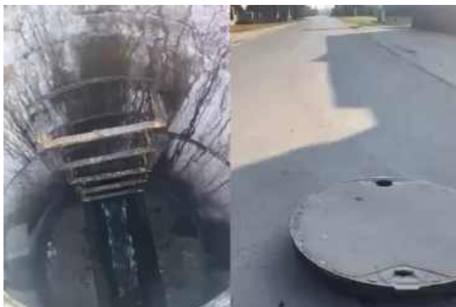
Po lewej płynące ścieki w kanalizacji burzowej. Po prawej kadr wykonany w tym samym momencie pokazujący, że jest sucho - nie padał deszcz
