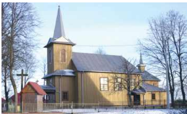
Zabytkowy kościół w Bukowej otrzymał dotację na remont w kwocie 394 tys. zł
