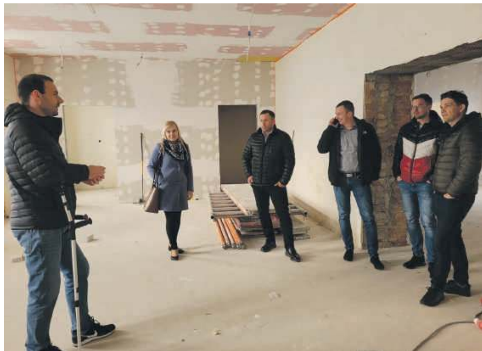
Postęp prac oceniał Burmistrz Gminy Prusice Igor Bandrowicz, wraz z pracownikami Urzędu Miejskiego w Prusicach oraz jednym z Wykonawców inwestycji
