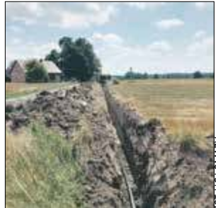
Prace rozpoczęły się z końcem lipca. Zakończenie robót zaplanowano na listopad tego roku
