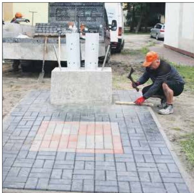
Trwają prace przy instalacji monumentu, który stanie przy izbie pamięci tworzonej przez bialski oddział Stowarzyszenia Seniorów Lotnictwa Wojskowego RP
