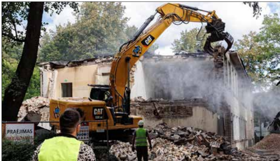
W 1964 r. na miejscu wyburzonej synagogi wybudowano przedszkole, w 2025 r. budynek został rozebrany Fot. Marian Paluszkievicz
