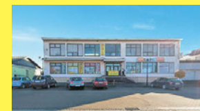
Dom handlowy w samym centrum Janowa Podlaskiego, 885 851 161
