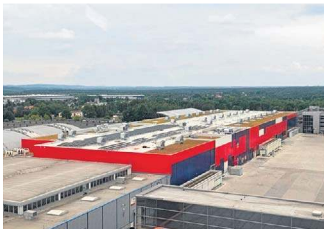
Nowa hala wyróżnia się rozwiązaniami proekologicznymi. Na dachu zamontowano instalację fotowoltaiczną
