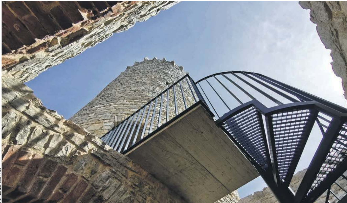
Schody prowadzące do wieży zamku Lipowiec
