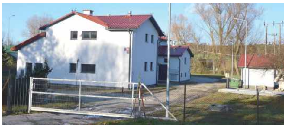
Spółka Bionor wygrała przetarg na zaprojektowanie i wykonanie rozbudowy oczyszczalni ścieków w Chodlu. Umowa zawarta została w sierpniu 2021 roku. A roboty odebrane w maju 2023 roku
