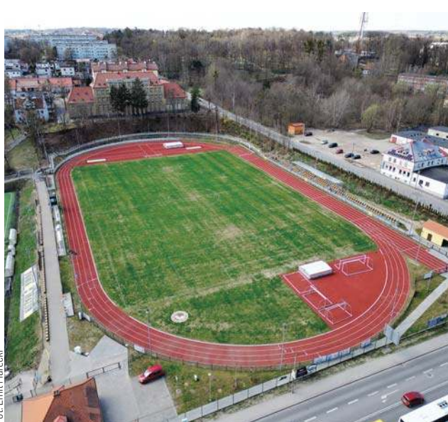
Zmodernizowany stadion w Mrągowie
