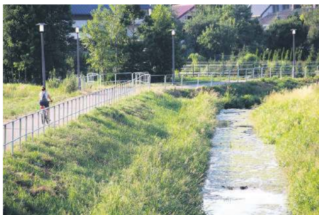
Łabuńka. Widok z mostu przy ul. Okrzei.
