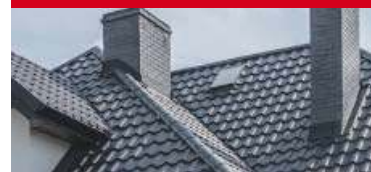
Kompleksowe pokrycia dachowe tel. 739 011 775 Myszków ul. Dworska 69
