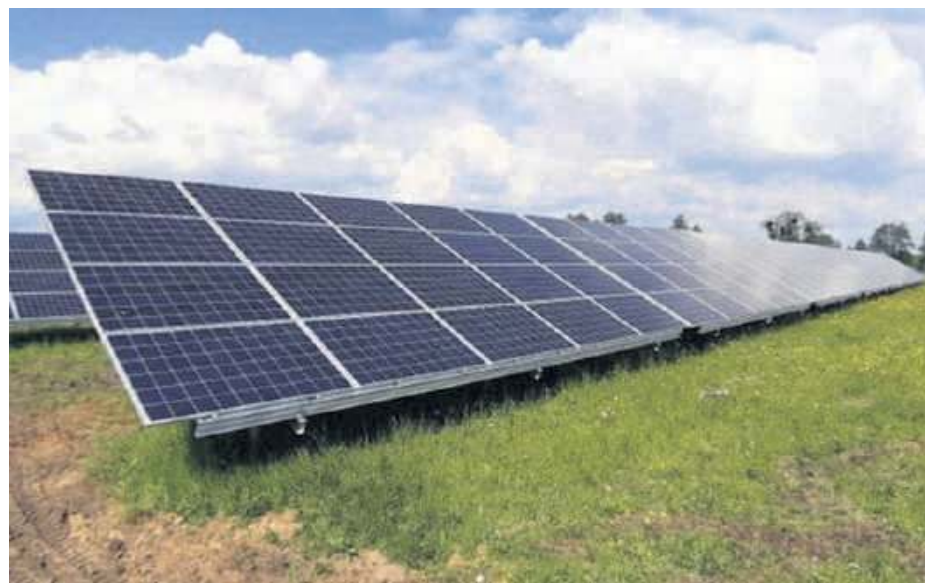
Budowa farmy fotowoltaicznej w Muchowcu prawdopodobnie rozpocznie się już tej jesieni. Fot. ilustracyjne
