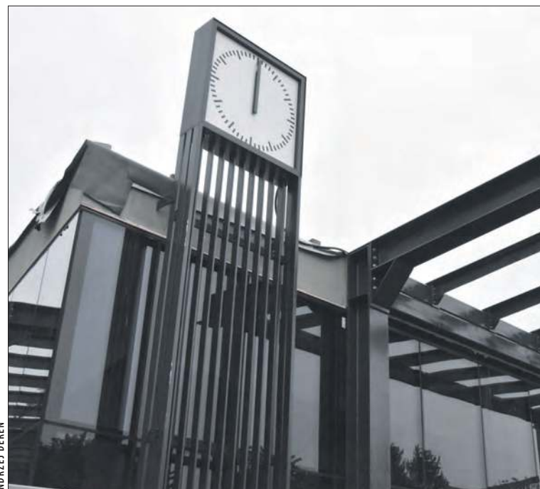
Zegar znajduje się w części budynku dworcowego od strony skrzyżowania ulic Kościuszki i Sądowej
