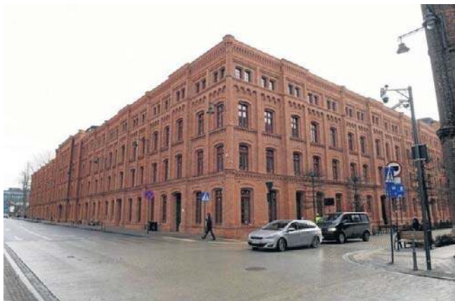
Są już gotowe pierwsze mieszkania w zabytkowej famule Poznańskiego, w której dobiega gruntowny remont
