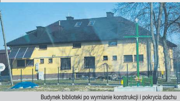
Budynek biblioteki po wymianie konstrukcji i pokrycia dachu
