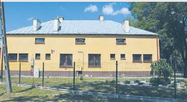
Budynek biblioteki przed wymianą konstrukcji i pokrycia dachu
