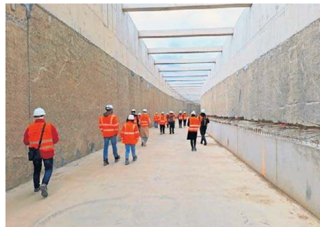
Prace w tunelu zostały wstrzymane już wiele dni przed tym, jak PKP PLK odstąpiło od umowy z wykonawcą
