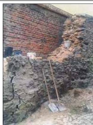
Prace remontowe są w trakcie.
