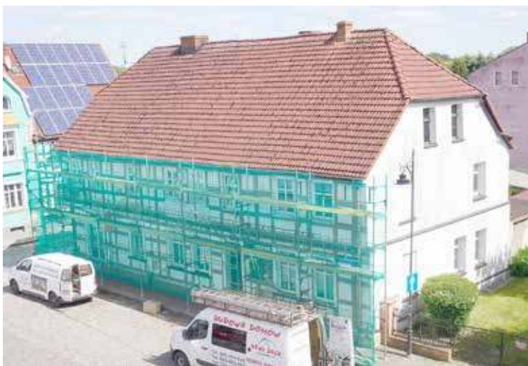
Prowadzony jest remont zabytkowego domu (fot. Gm. Maszewo)
