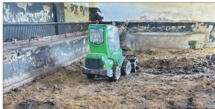
Wnętrze stajni przed uporządkowaniem
