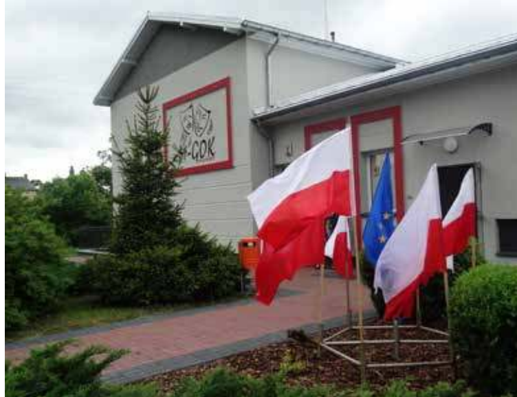
Siedziba Miejsko-Gminnego Ośrodka Kultury w Mordach (po remoncie)
