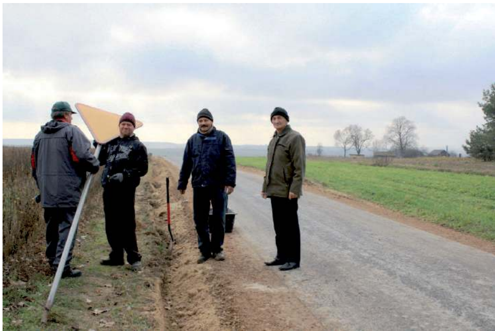
Przebudowa dwukilometrowego odcinka drogi relacji Grądy – Ratoszyn – Granice na finiszu. Wójt Majewski doglądał każdej inwestycji osobiście
