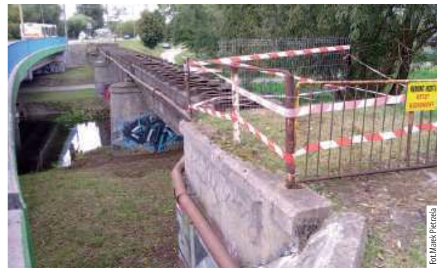
Zdemontowano już niebezpieczne elementy mostu. Solidna konstrukcja stalowa czeka na dalsze prace
