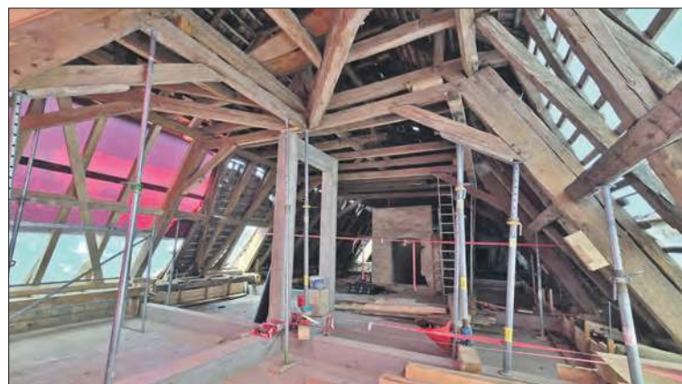
Strych remontowanego skrzydła z częściowo zdjętymi dachówkami i wylanym betonem stropu
