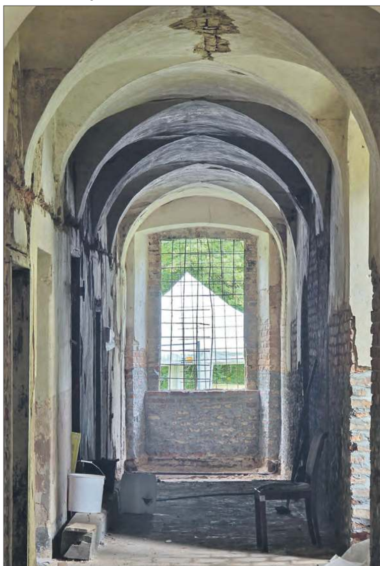
Korytarz skrzydła południowo-zachodniego tak jak kiedyś ciągnie się wzdłuż całej jego długości. Wcześniej na jego końcu znajdowała się toaleta.
