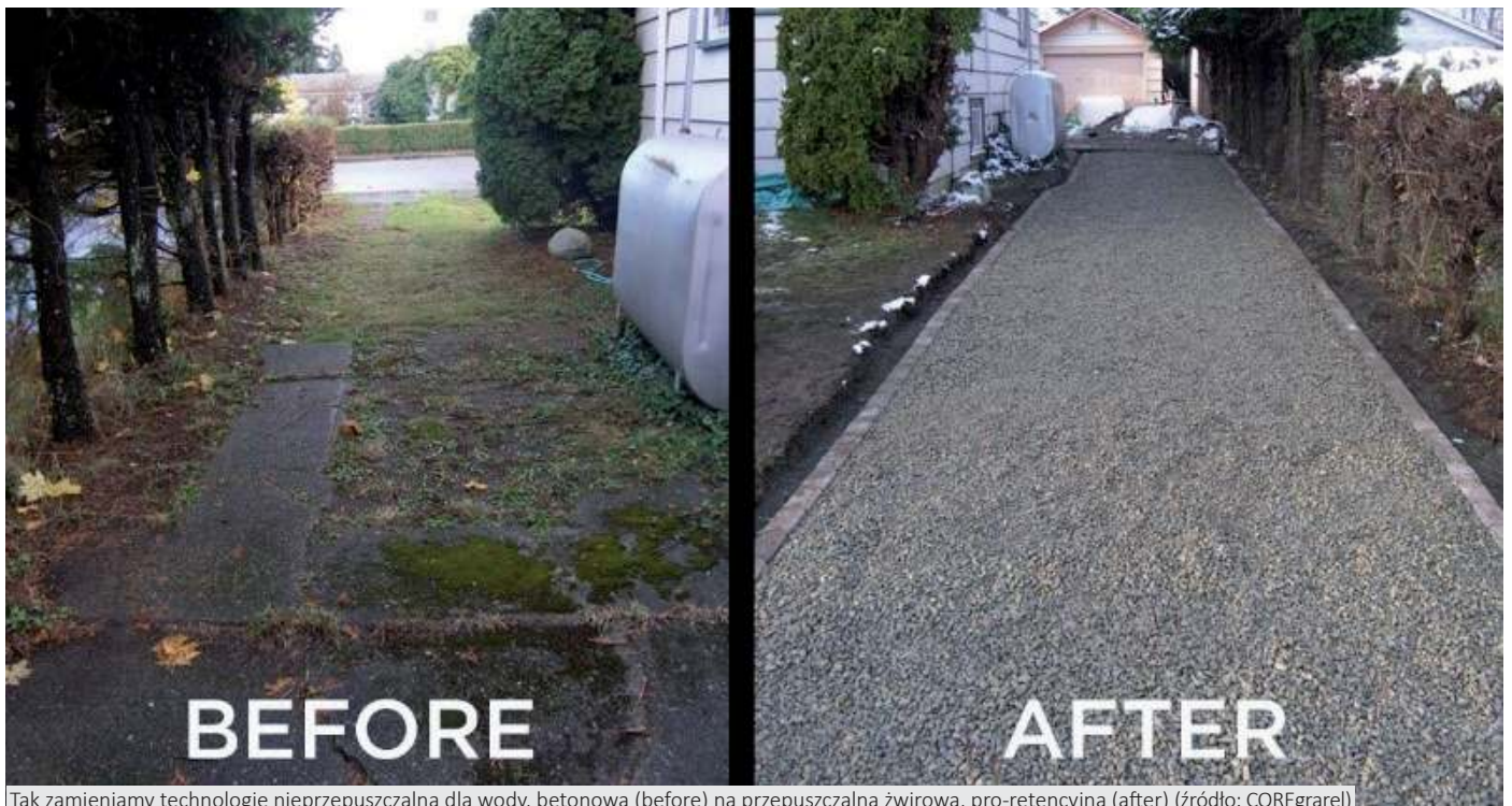
Tak zamieniamy technologię nieprzepuszczalną dla wody, betonową (before) na przepuszczalną żwirową, pro-retencyjną (after) (źródło: COREgrarel)
