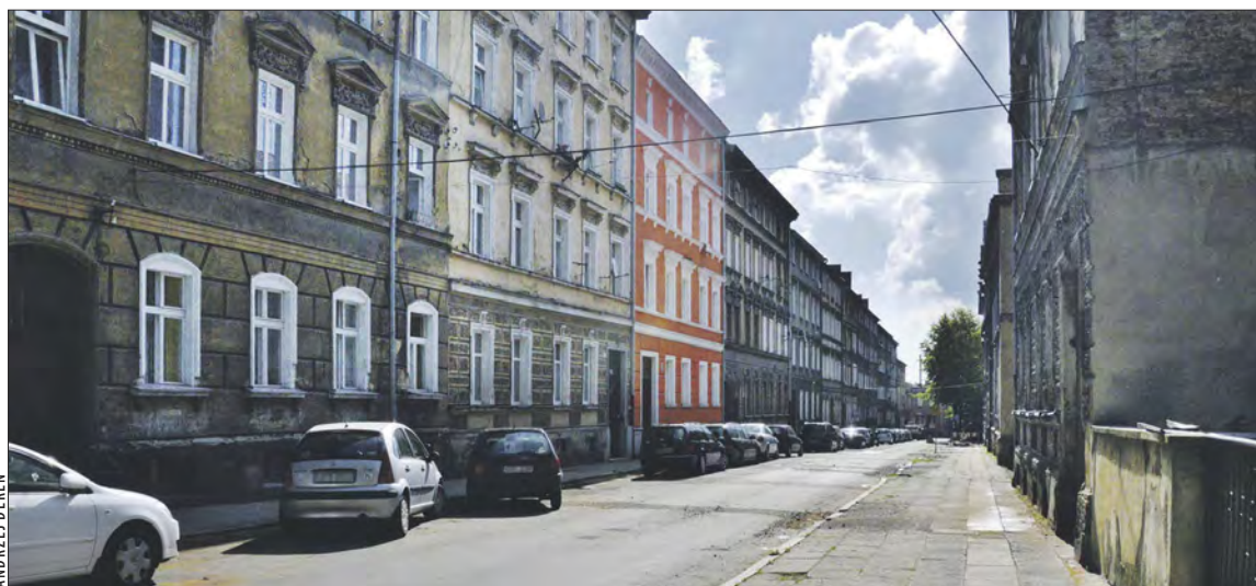
Miejska sieć ciepłownicza zaczyna obejmować również stare budownictwo
