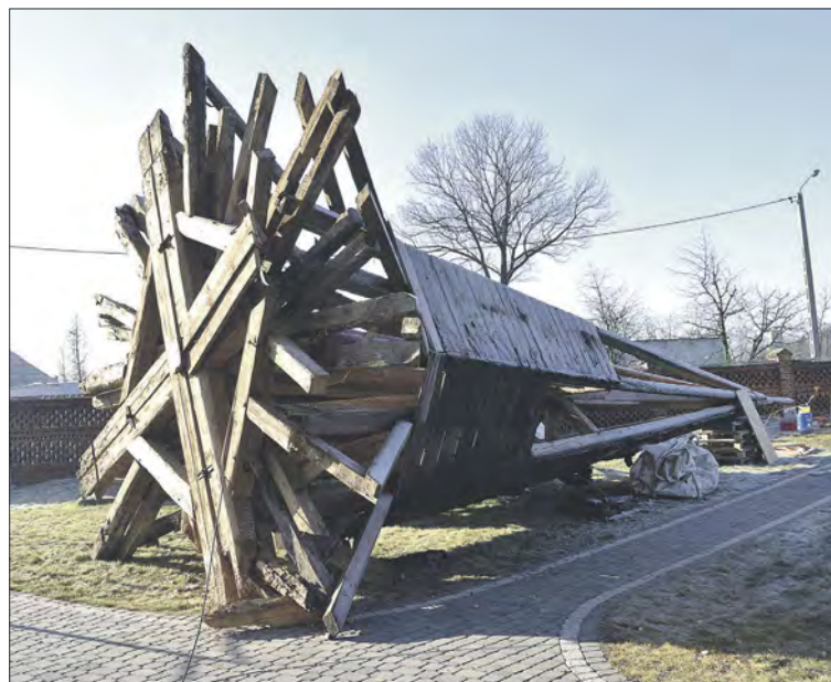
15 stycznia hełm z pomocą dźwigu został zdjęty ze szczytu wieży. Dwa dni później znaleziono tuby – „kapsuły czasu”
