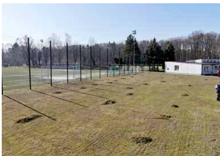
Prace na stadionie pomiędzy budynkiem klubowym a boczną płytą boiska
