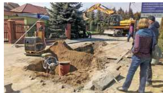
Budowa sieci kanalizacyjnej ul. Wiśniowa i Winogronowa
