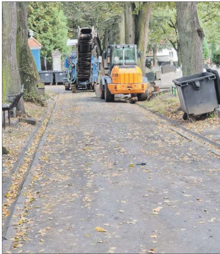
Prace na terenie cmentarza
