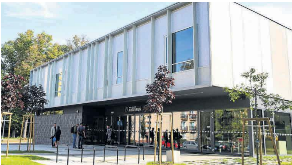
Koszt budowy nowego domu kultury w Podjuchach to prawie dziesięć milionów złotych
