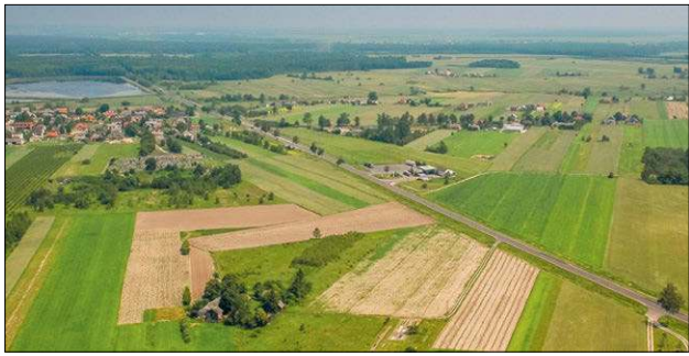
Dwujezdniowa trasa ekspresowa o długości 18,1 km powstanie w istniejącym korytarzu drogi krajowej nr 19.
