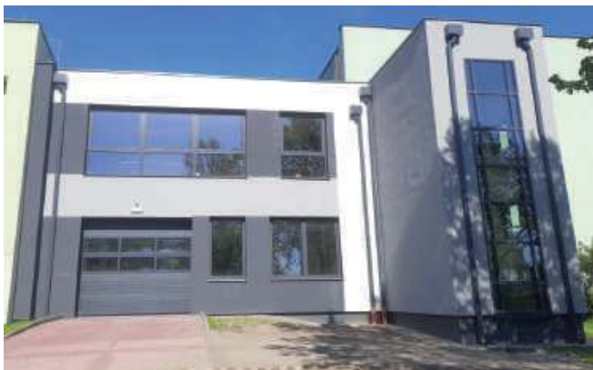
Tak na zewnątrz prezentuje się dwukondygnacyjny obiekt, powstały między salą gimnastyczną a głównym budynkiem szkoły. Jego budowa trwała kilka miesięcy
