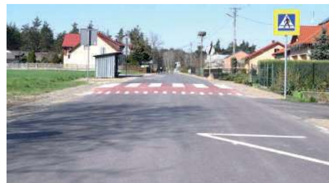
Remont dróg na terenie gm. Baranów zakończono szybciej niż się spodziewano. Całość miała być ukończona do końca sierpnia br. Odbiór techniczny nastąpił jednak trzy tygodnie temu
