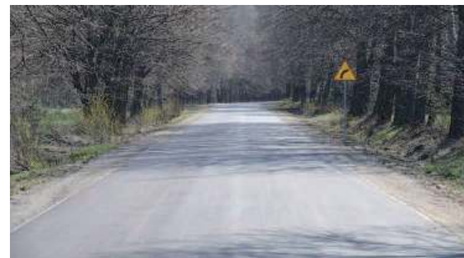
Długość przebudowanego odcinka drogi łączącej Baranów, Zagożdź i Dębczynę wynosi 4,9 km. Mieszkańcom tych miejscowości umożliwi to szybszy dojazd np. do pracy czy szkoły
