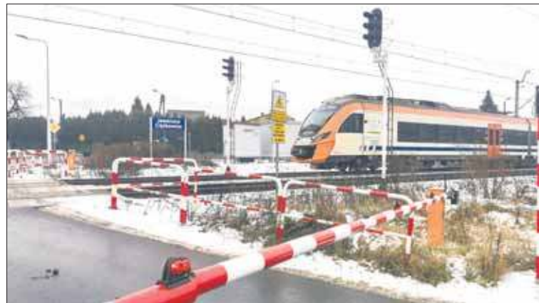
Wiadukt ma zostać ukończony w 2023 roku
