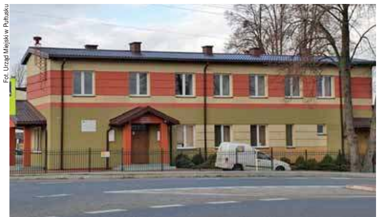
Dach świetlicy został naprawiony
