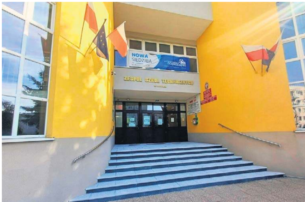
ZST Malbork z nowymi schodami przed wejściem głównym
