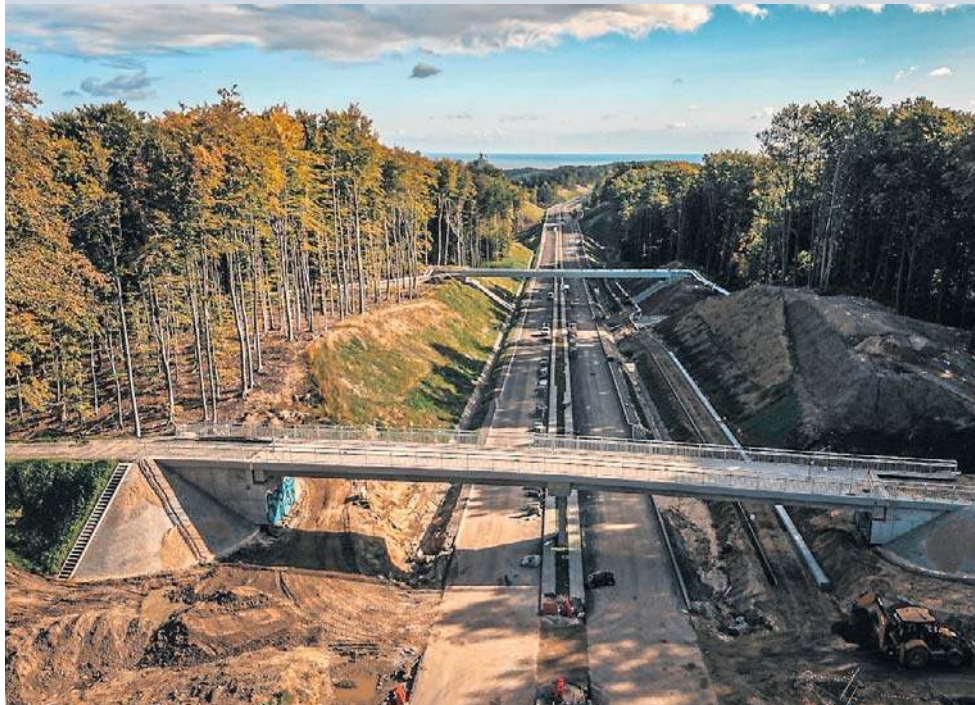
Prace są bardzo zaawansowane
