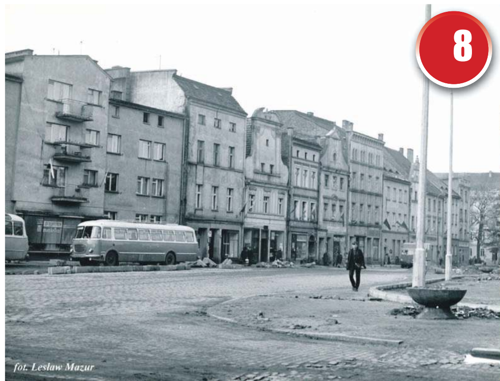
To zdjęcie zrobiłem w 1970 roku. Rozpoczyna się remont placu rynkowego, na zdjęciu widać, że zmieniono układ placu, są już nowe krawężniki i widać, jak były położone stare krawężniki. Są też nowe słupy betonowe oświetleniowe, widać charakterystyczną betonową donicę na kwiaty
