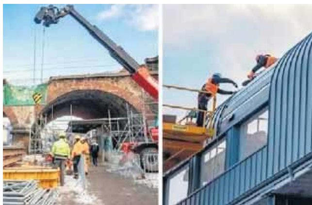
Trwają prace przy rozbiorze wiaduktu, w sąsiedztwie prowadzone są roboty związane z budową przystanku Kraków-Grzegórzki
