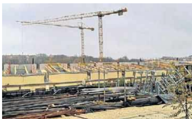
Budowa Cogiteonu - konstrukcja pnie się już w górę przy alei Bora-Komorowskiego
