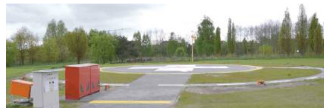
Obok SPZOZ-u zbudowano lądowisko dla helikopterów
