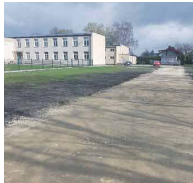
Takiej jakości skrót ułatwia, czy też utrudnia dojście i dojazd do budynków przy ulicy Młyńskiej?
