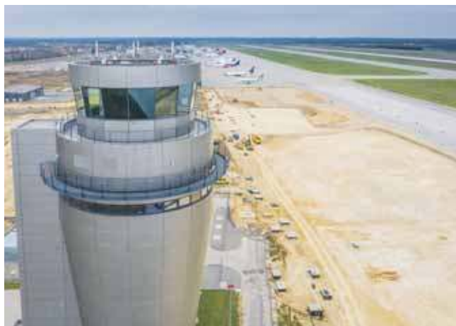
Płyta postojowa powstaje przed działką, na której trwa budowa trzeciego hangaru (na zdjęciu zaściana go wieża)
