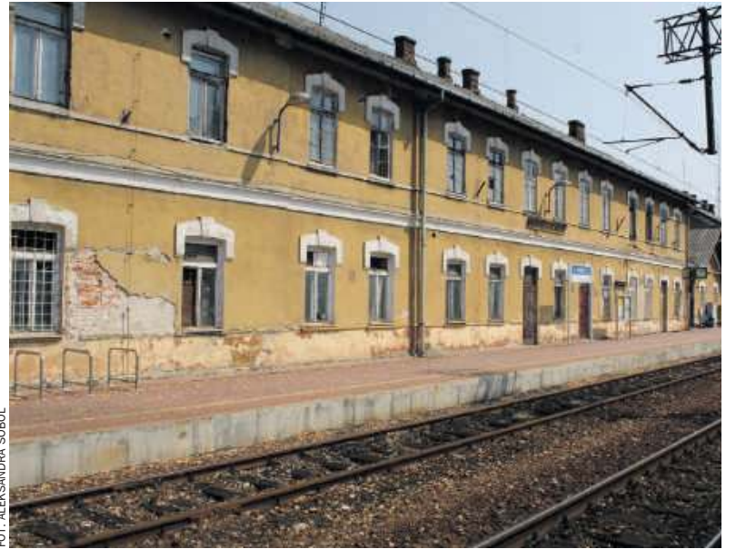
W zmodernizowanym dworcu kolejowym w Stalowej Woli-Rozwadowie zlokalizowane zostaną powierzchnie komercyjne
