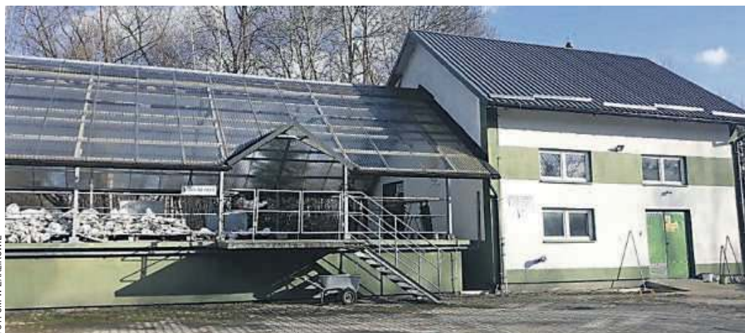
Oczyszczalnia ścieków przed modernizacją
