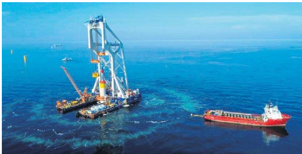
Budowa morskiej farmy wiatrowej Baltic Power
