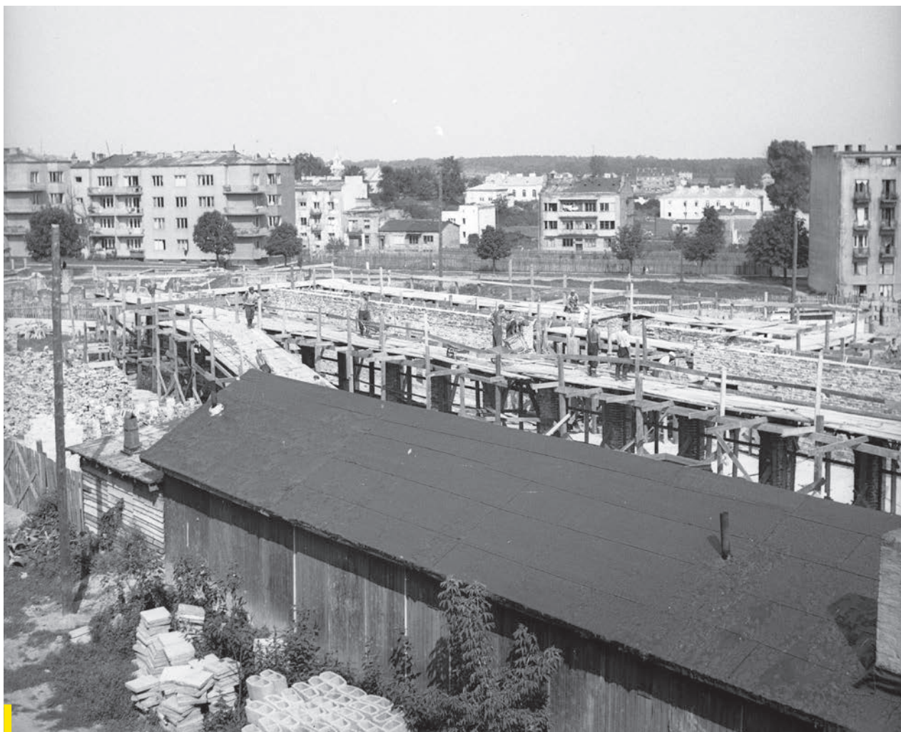
Budowa biblioteki WOSP (1950?), źródło: NAC
