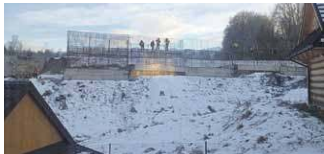
Robotnicy się uwijają, na starym nasypie budują mur oporowy, na nim wylądują tory, pociągi będą jeździć nad domami.
