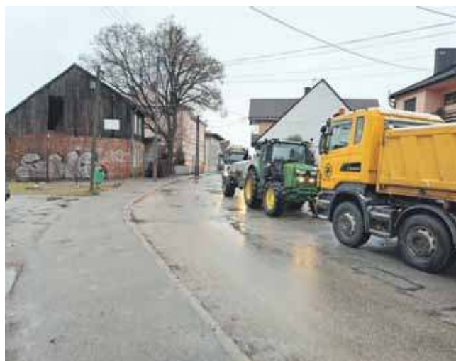
We wtorek rozpoczął się remont ul. Nadwodniej.
