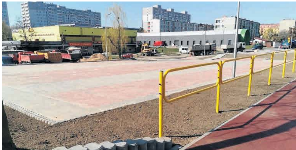
Nowy parking przy ulicy Szpitalnej to część węzła przesiadkowego w Czeladzi
