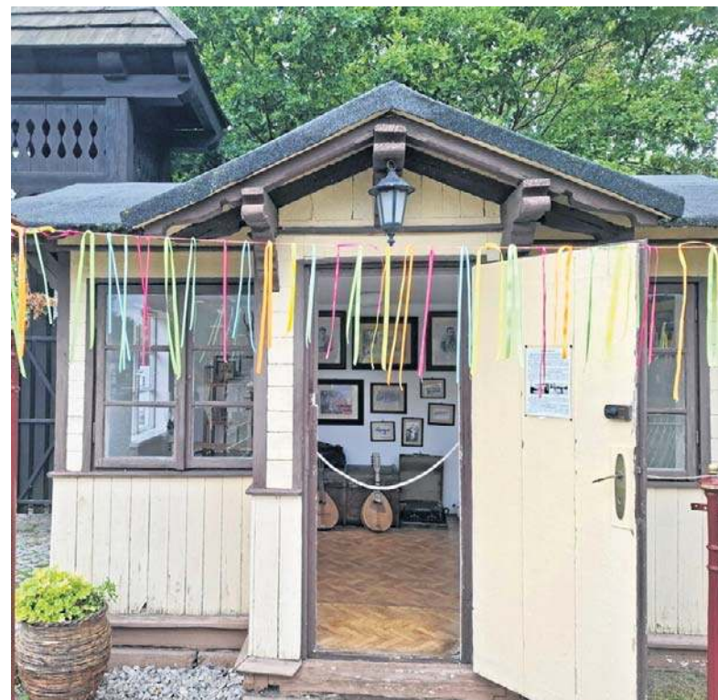
Budynek toalety stał pierwotnie w lasach spalskich
