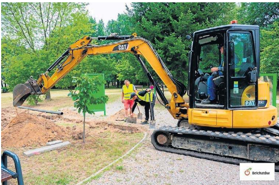
Trwa modernizacja w parku im. im. Samujłły w Bełchatowie
