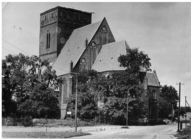
Widok na Kościół bez dachu
