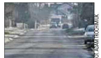
Modernizację ul. Siderskiej miasto chce rozpocząć od odcinka między Al. Solidarności a rogatkami miasta w kierunku Czosnówki
