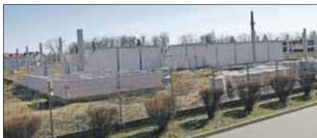
Dziś na placu budowy galerii Karuzela niewiele się dzieje
