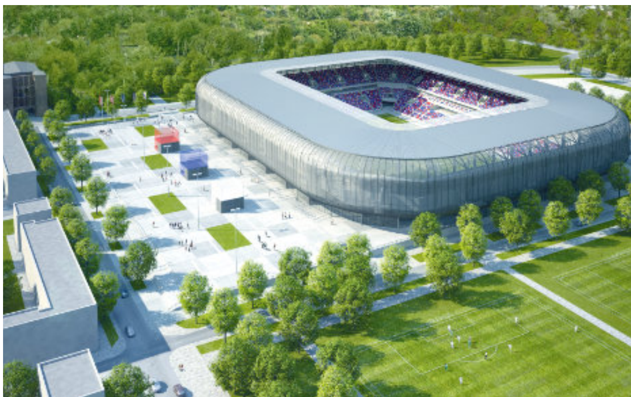
► Tak stadion przy ul. Roosevelta ma wyglądać po zakończeniu prac Fot. UM Zabrze
