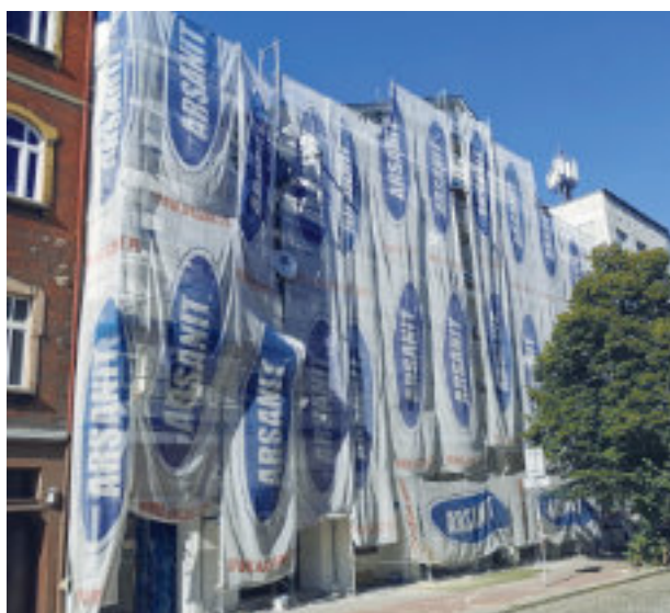
▶ Remontowaną elewację zastaniają jeszcze rozpięte na rusztowaniu siatki Fot. Igor Cieśliski
